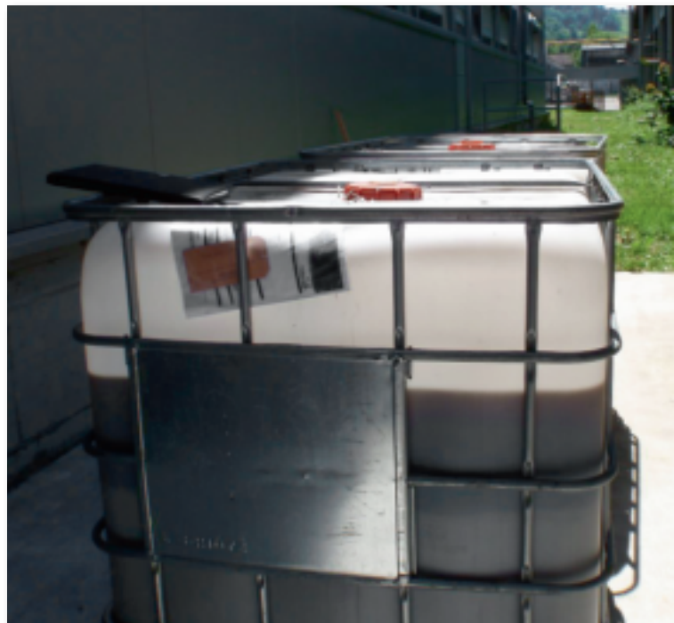
Abb. 3: Chemikalien in Containern im Freien ohne Auffangwanne gelagert.
