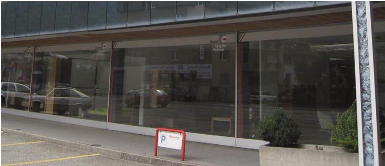
3 Eine grosse Fensterfront kann zu einem riesigen Wärmeverlust führen, bei Sonneneinstrahlung aber auch einer Solarheizung gleichgesetzt werden.
